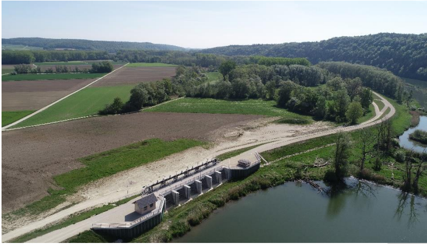
in den Stauhaltungsdamm der Staustufe Bittenbrunn integriertes Einlaufbauwerk zur Polderfüllung (Quelle: Wasserwirtschaftsamt Ingolstadt)
