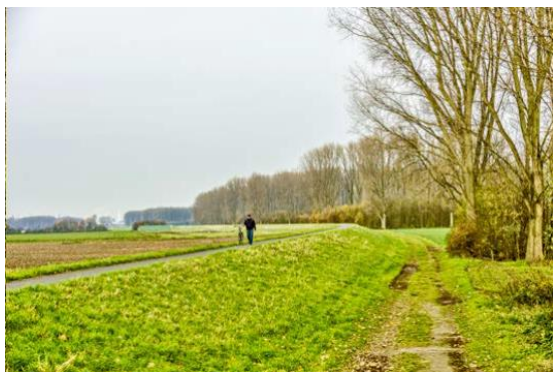
Vorhandener Rheindeich (Quelle: StFB Köln)
