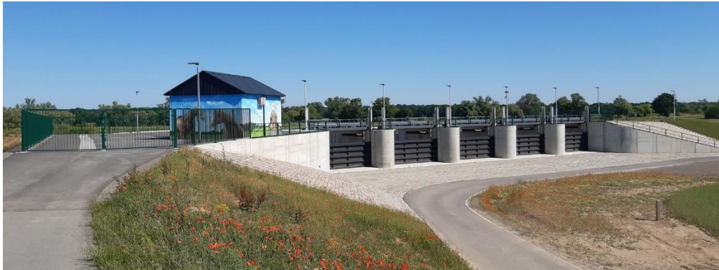
Auslaufbauwerk (Quelle: Landestalsperrenverwaltung Sachsen, Betrieb Elbe/Mulde/Untere Weiße Elster)
