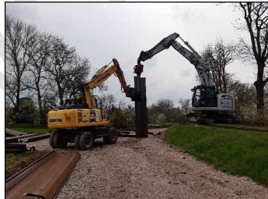
Ersatzneubau Deich bei Ringleben, 04/2022 (Quelle: TLUBN)
