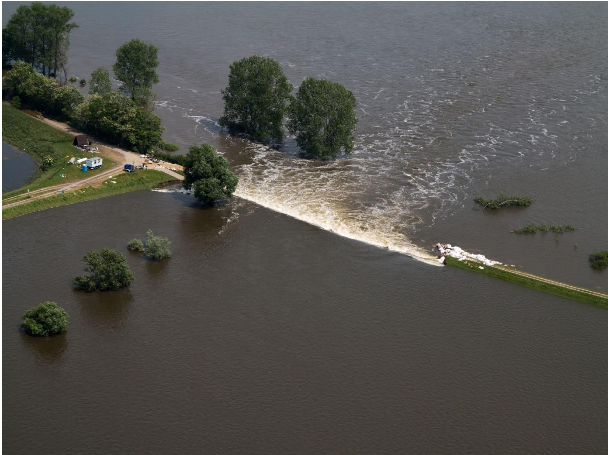
Abbildung 3: Der Deichbruch bei Fischbeck am 10.06.2013, Hochwasser strömt durch die Deichbruchstelle (Quelle: Sven Schulz, Ministerium für Wissenschaft, Energie, Klimaschutz und Umwelt Sachsen-Anhalt)
