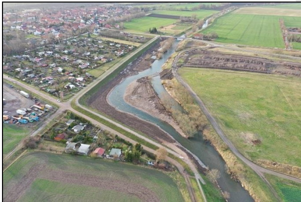
Deichrückverlegung und Gewässerstrukturierung bei Walsleben, 04/2020 (Quelle: TLUBN)
