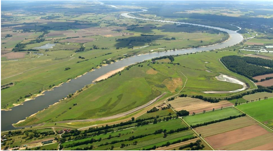
Bereich der Deichrückverlegung Vitico in Blickrichtung Oberstrom (Quelle: Bildrecht NLWKN, Urheberrecht Falcon Crest Air)
